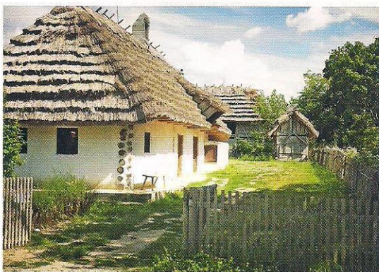
Nádtetővel fedett, boronafalazással épült ház. Jól látható, hogy a fatörzseket túlnyújtották a ház sarkainál. A gerendák hézagait kívül és belül is sárral tapasztották be, majd bemeszelték.
