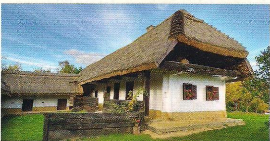
Zsuppal fedett, csonkakontyos, nyitott oromzatos, faoszlopos tornácós falusi lakóház és gazdasági épület, Őrség (Szalafő-Pityerszer).
